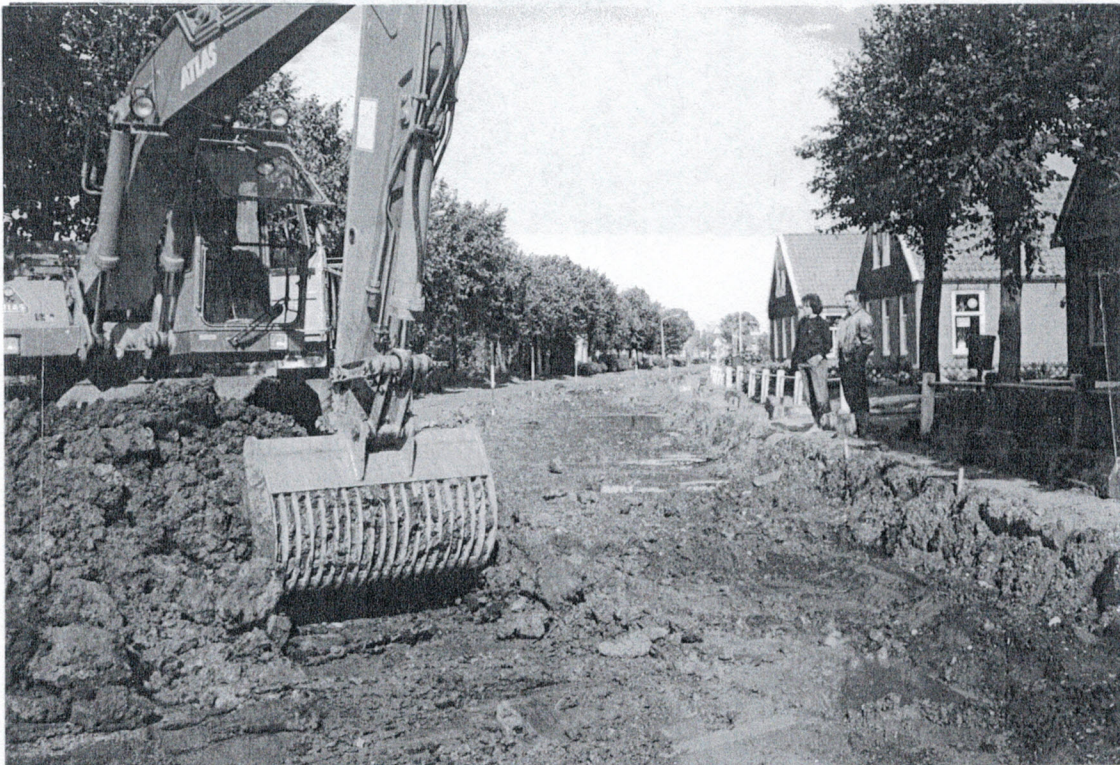
1983. Hier is Laurens van Maar bezig de Graauwedijk af te graven. Rechts staan mijn man en dochter Wilma toe te kijken, dit was balen!
